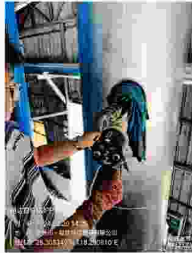
PI DA001 排气筒出口
